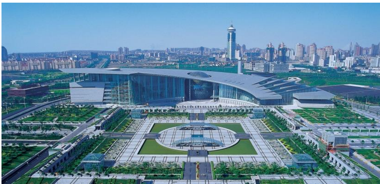
Рис. 1. Здание Шанхайского музея науки и техники, Шанхай КНР
